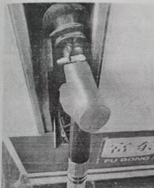
5.加油气回收真空压力阀照片
