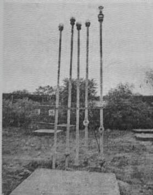
5.加油气回收真空压力阀照片
