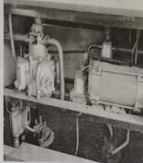
4.一次油气回收接头安装照片
