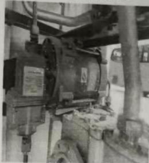
4.一次油气回收接头安装照片
