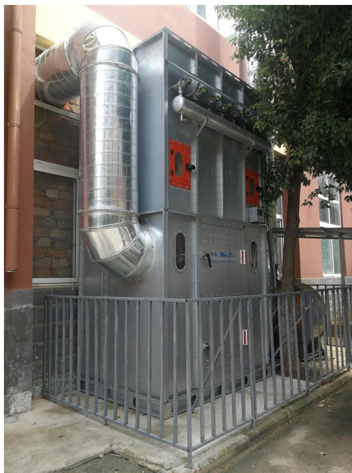
图 7-8 脉冲+袋式除尘器
