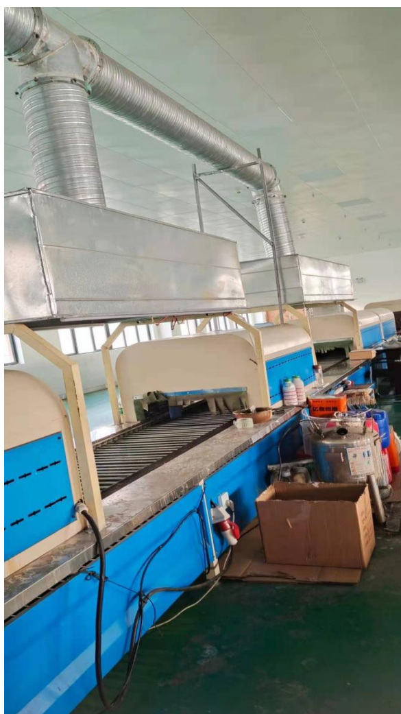
废气集气管道
