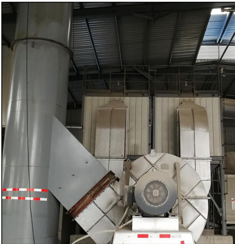
图 7-3 烘干废气处理
