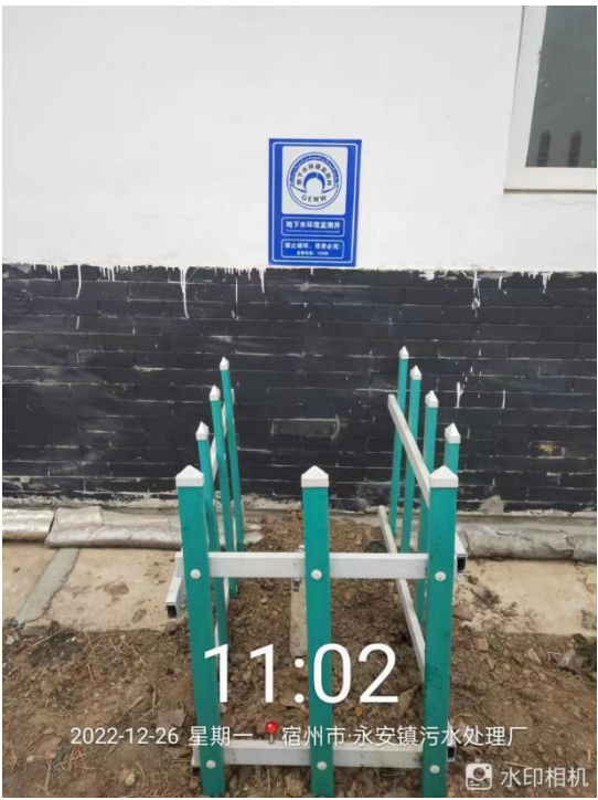
地下水监测井
