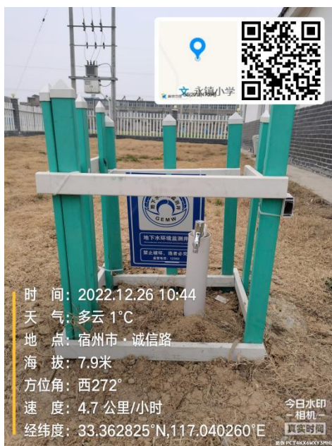
地下水监测井
