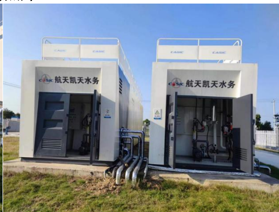
一体化污水处理设备
