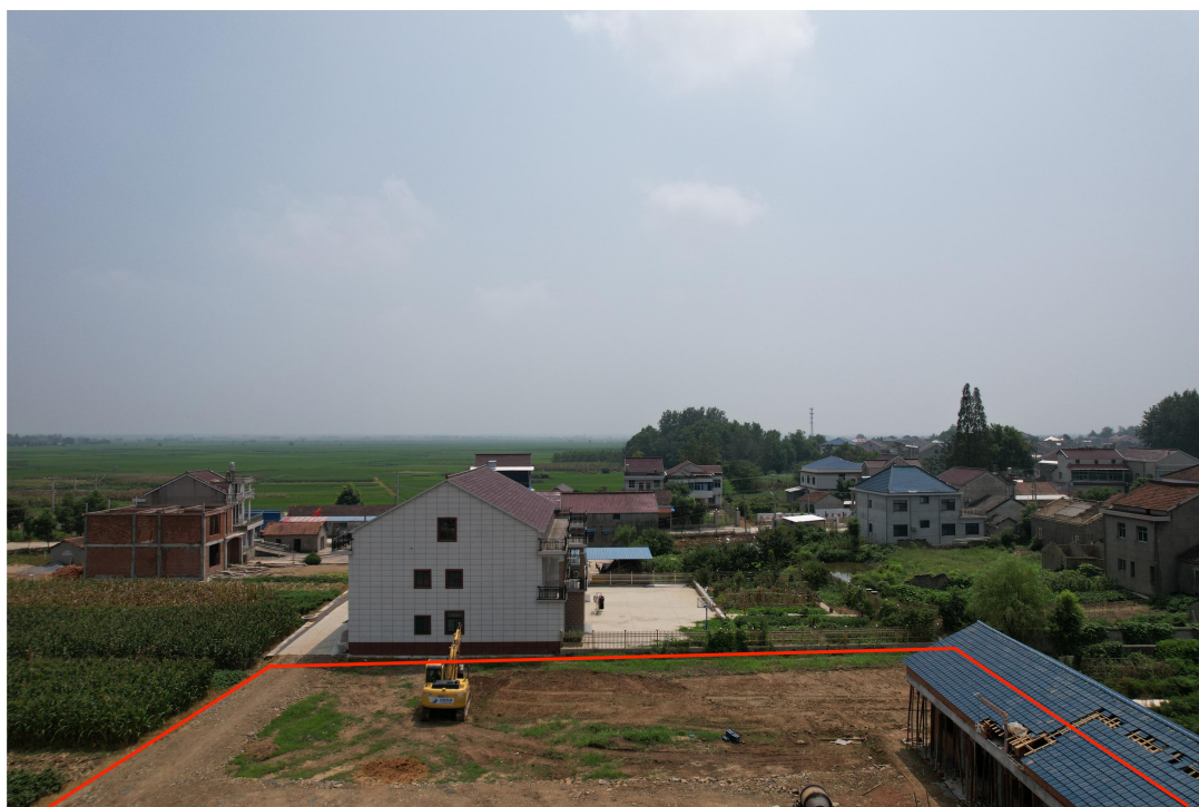
红线内为地块内东侧，显示为荒地，南侧沿边界可见在建房屋
