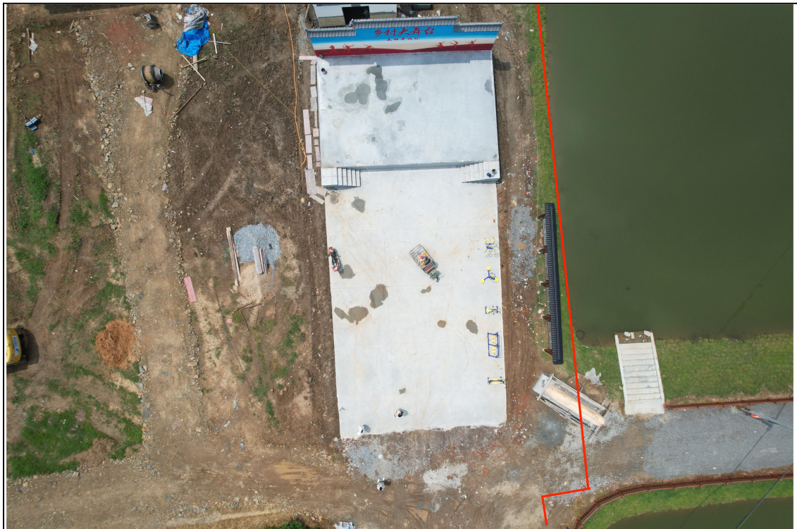
红线内为地块内西南部，可见水泥硬化现象
