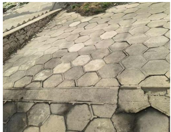
图 4-4、4 号码头泊位生态砌块护坡
