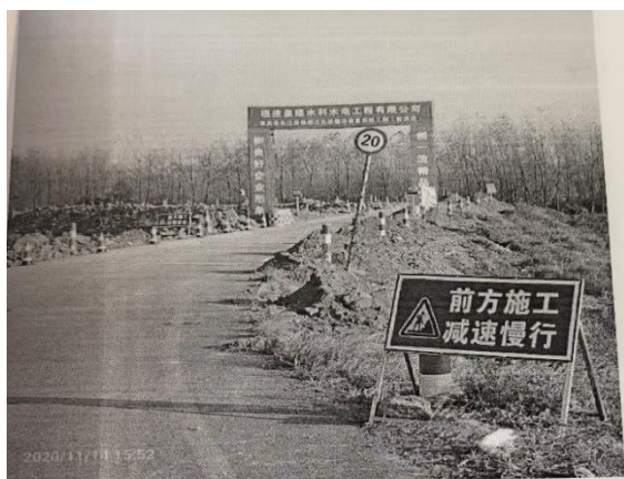
施工区警示牌
