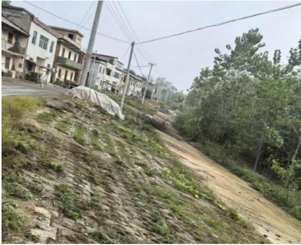
图 4-18、永乐圩混凝土板+生态砌块护坡图
