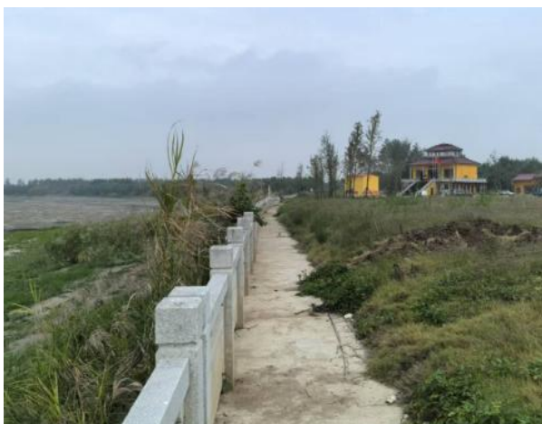
图 4-22、南木洲观景平台护栏
