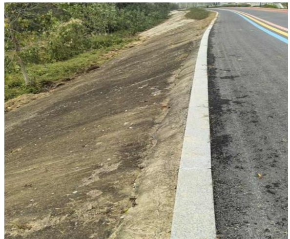
图 4-19、永乐圩混凝土板护坡
