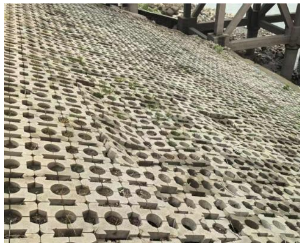
图 4-15、 11 号码头生态砌块护坡
