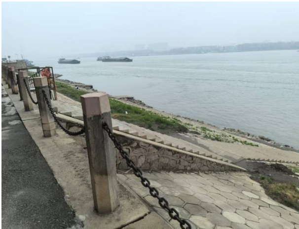
图 4-3、4 号码头泊位联锁式护栏
