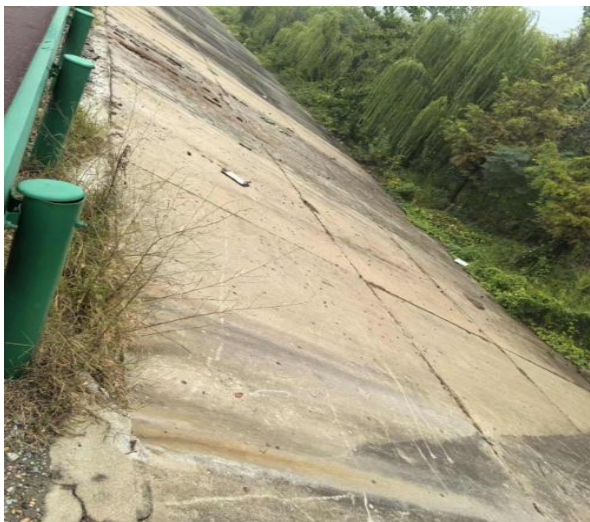
图 4-7、曙光码头混凝土板护坡
