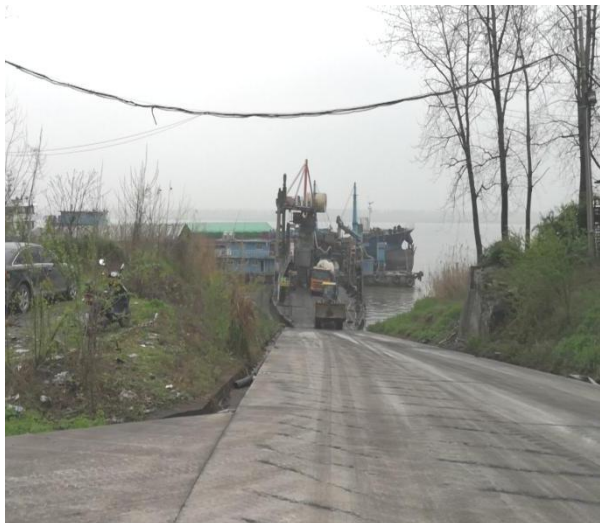
图 4-8、19 号码头施工前照片
