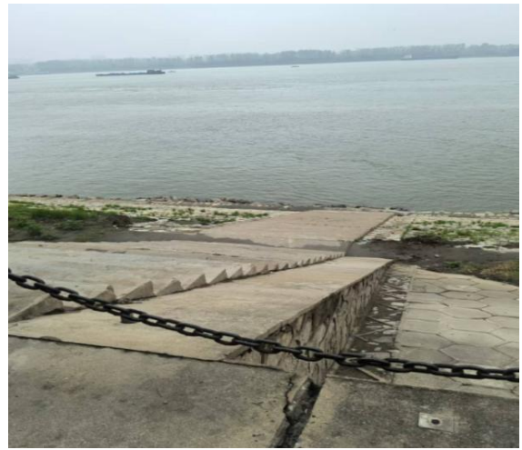
图 4-2、4 号码头泊位修复后照片
