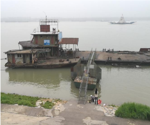
图 4-1、4 号码头泊位施工前照片
