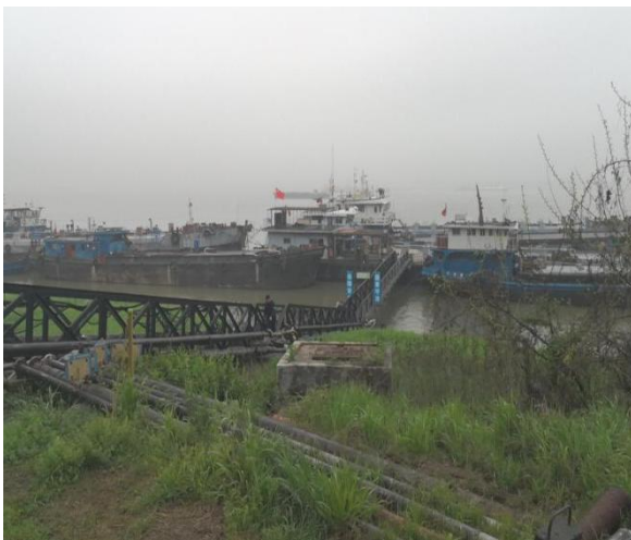
图 4-5、曙光码头施工前照片图
