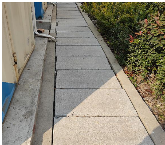
厂区雨水管线
