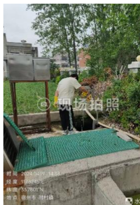
4 月 19 日污水站进口检测
