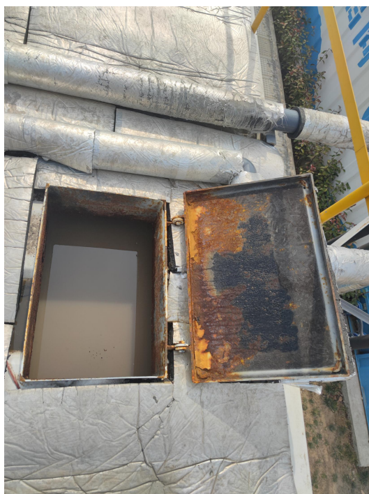
一体化处理设备处理过程
