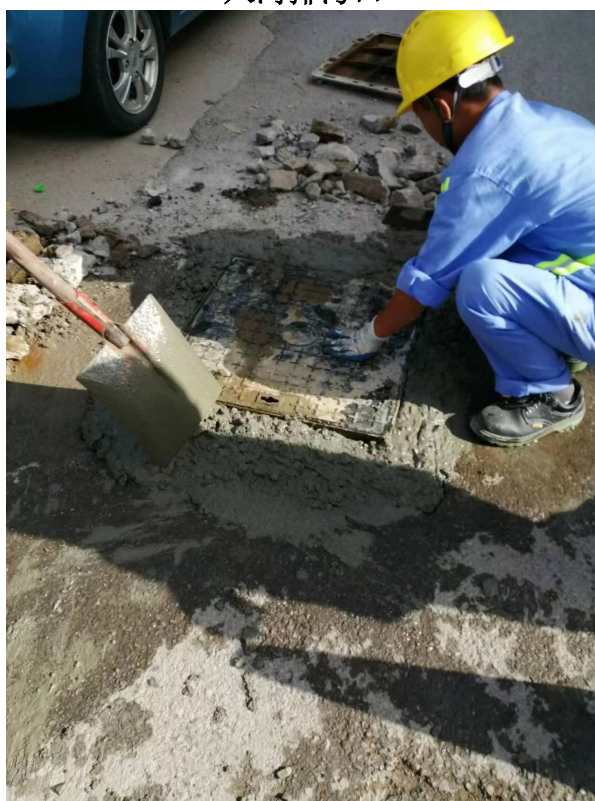
管网日常巡检维护
