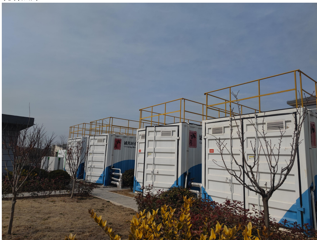
一体化污水处理设备
