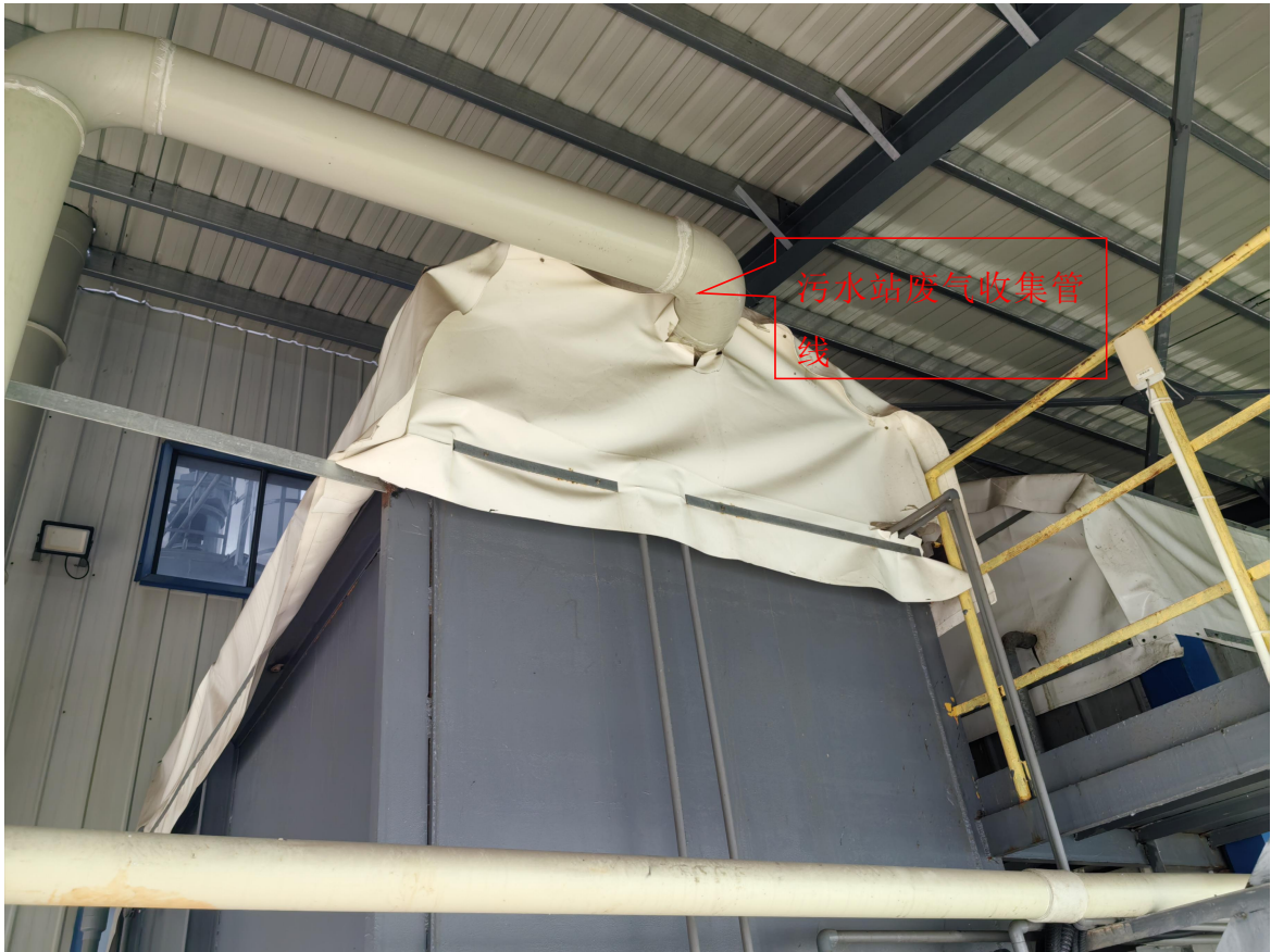
图 4.1-13 污水处理站废气收集
