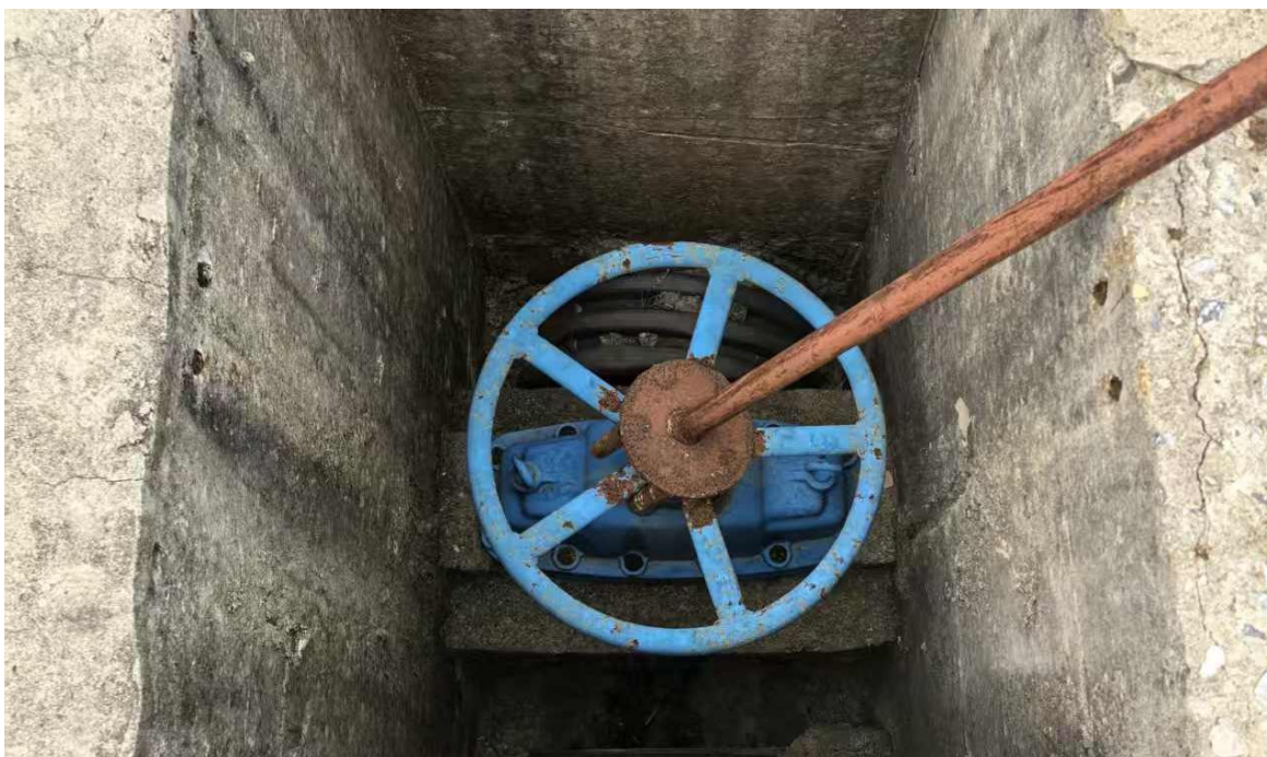
图 4.2-3 雨水切换阀
