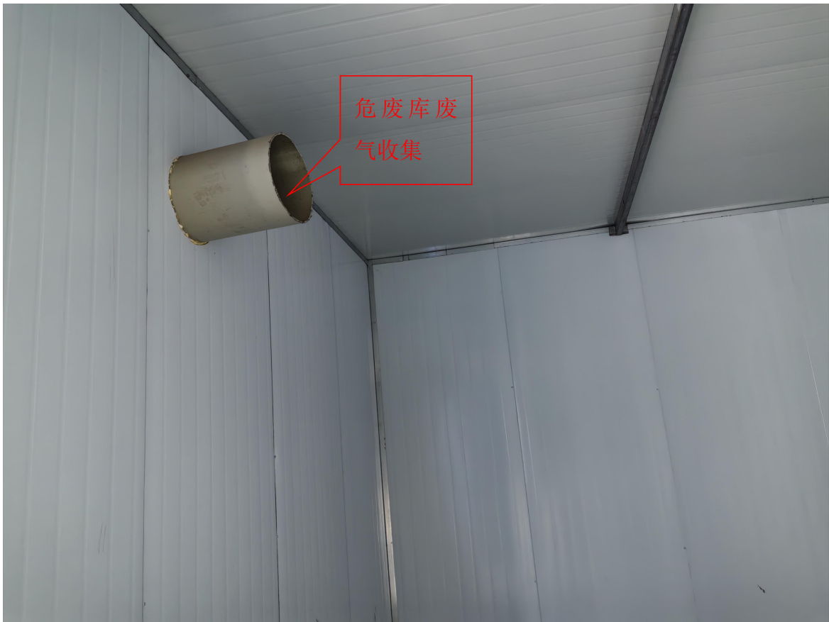
图 4.1-12 危废库废气收集
