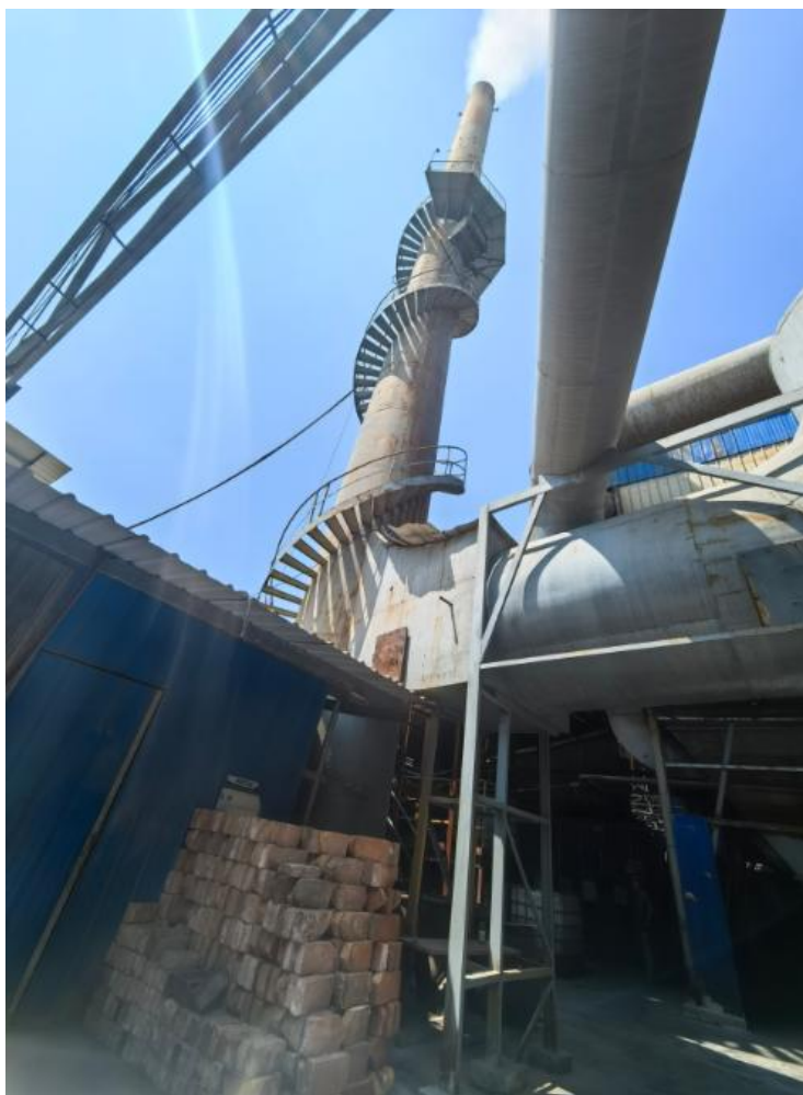
图 3-9 锅炉房排气筒
