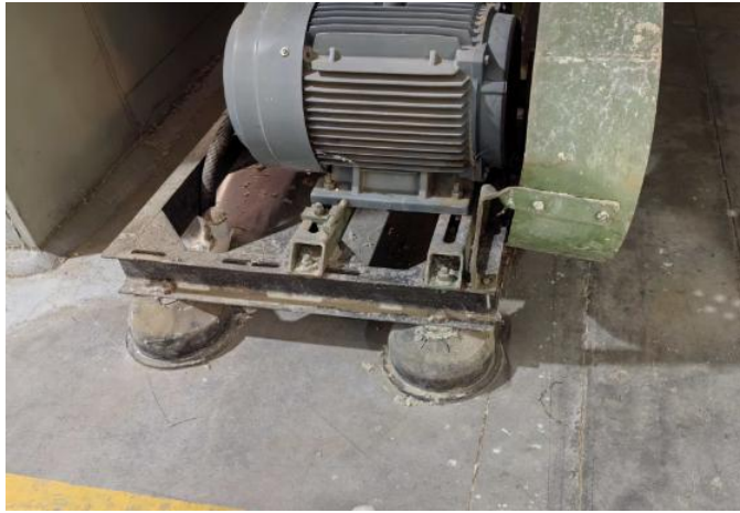
图 3-2 设备减震
