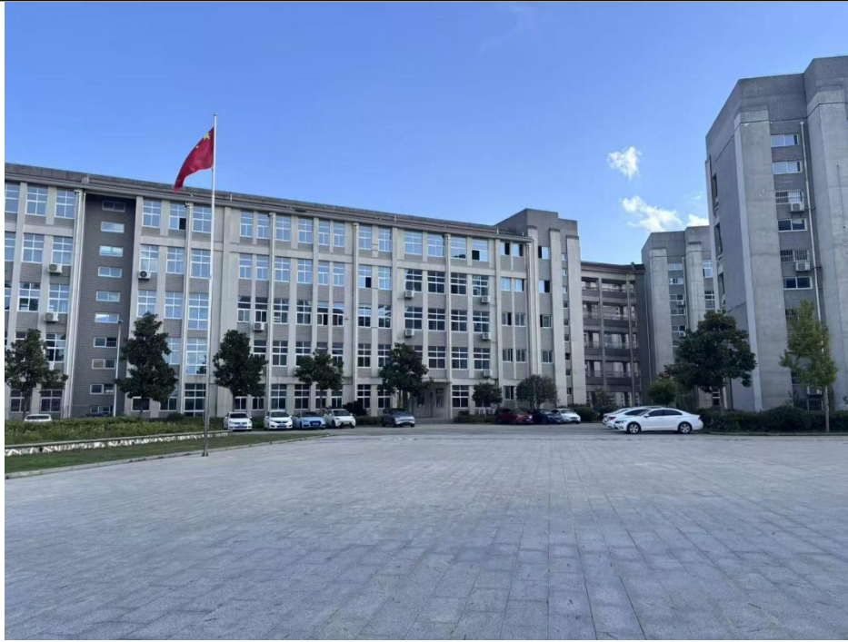
地块南侧 的教学楼
